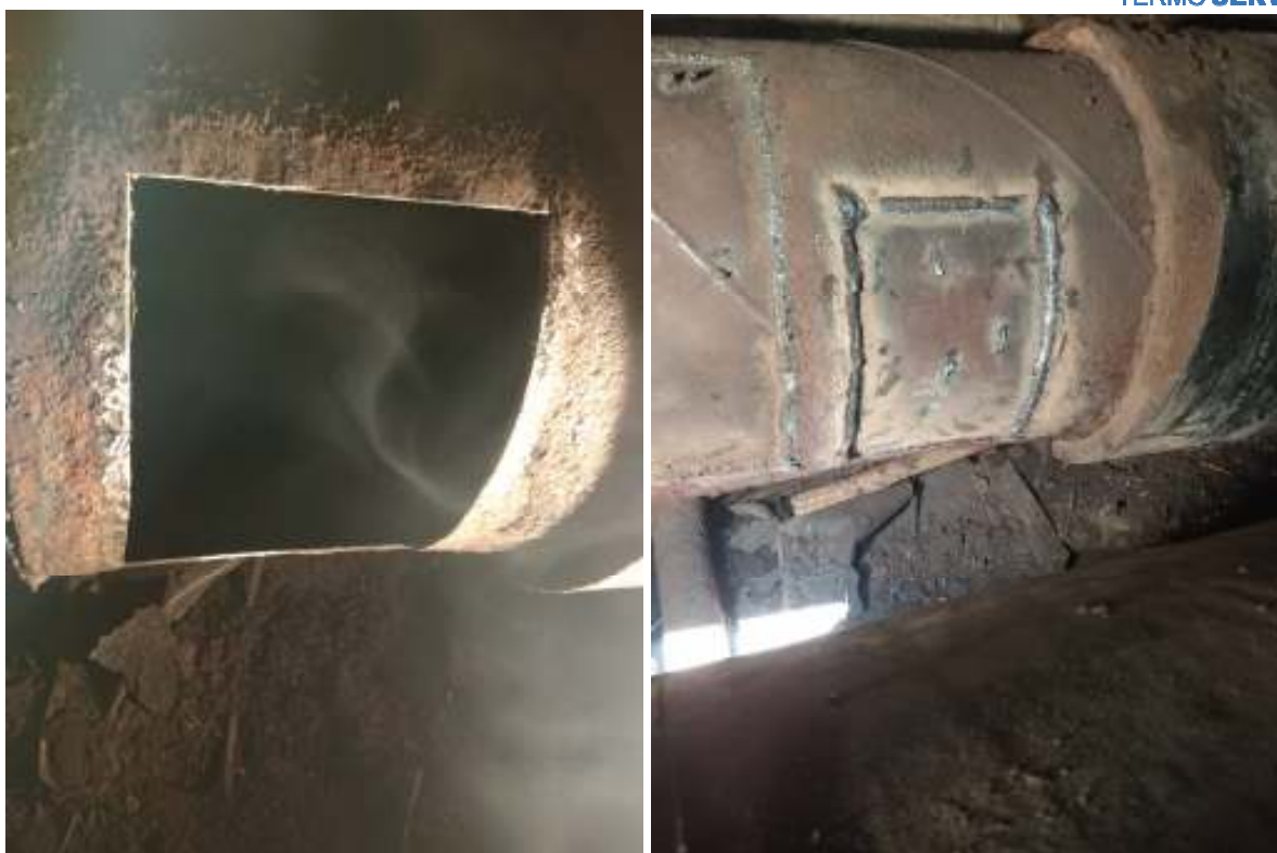
img 14, img 15 Rețea transport fir principal mag 5 B-dul Regele Ferdinand I
