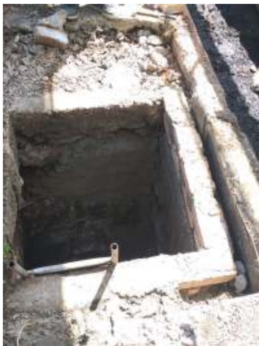
img 16, img 17 Decolmatarea rețea canalizare atelier rețele termice
