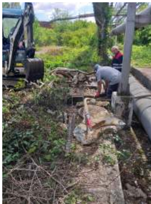
img 16, img 17 Decolmatarea rețea canalizare atelier rețele termice
