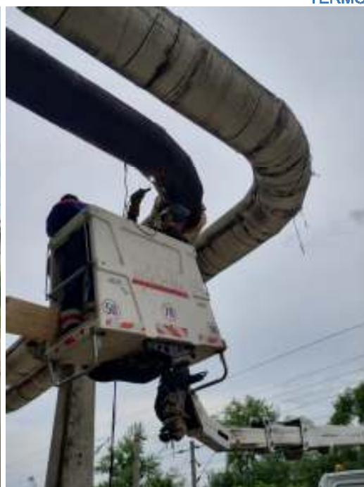
img 7, img 8 Rețea transport fir principal zona Luca Arbore lucru din nacelă
