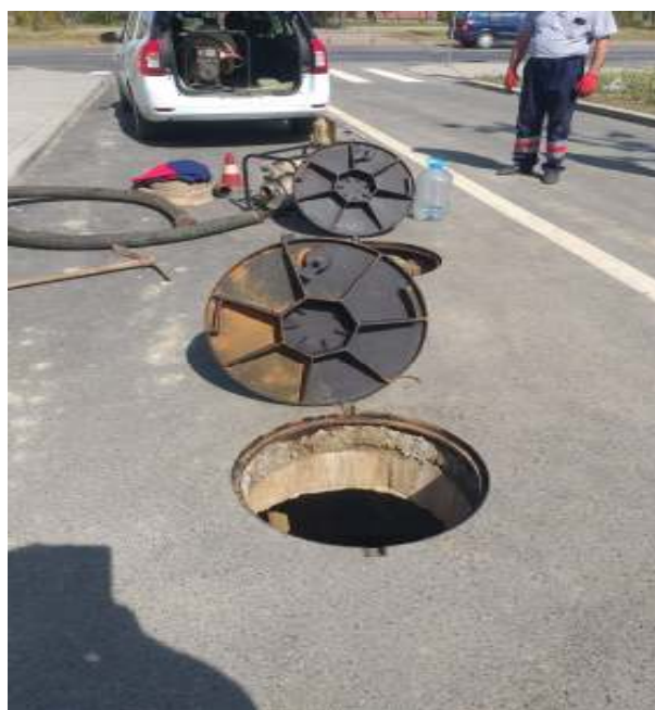
Img. 42 Activități - lucrări reparații rețele
